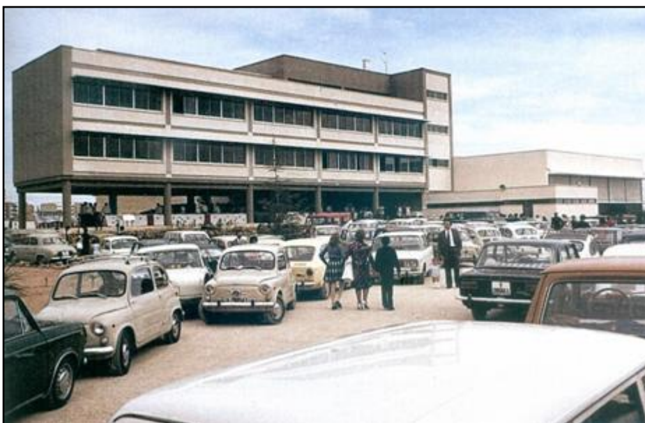
Vista general del colegio
