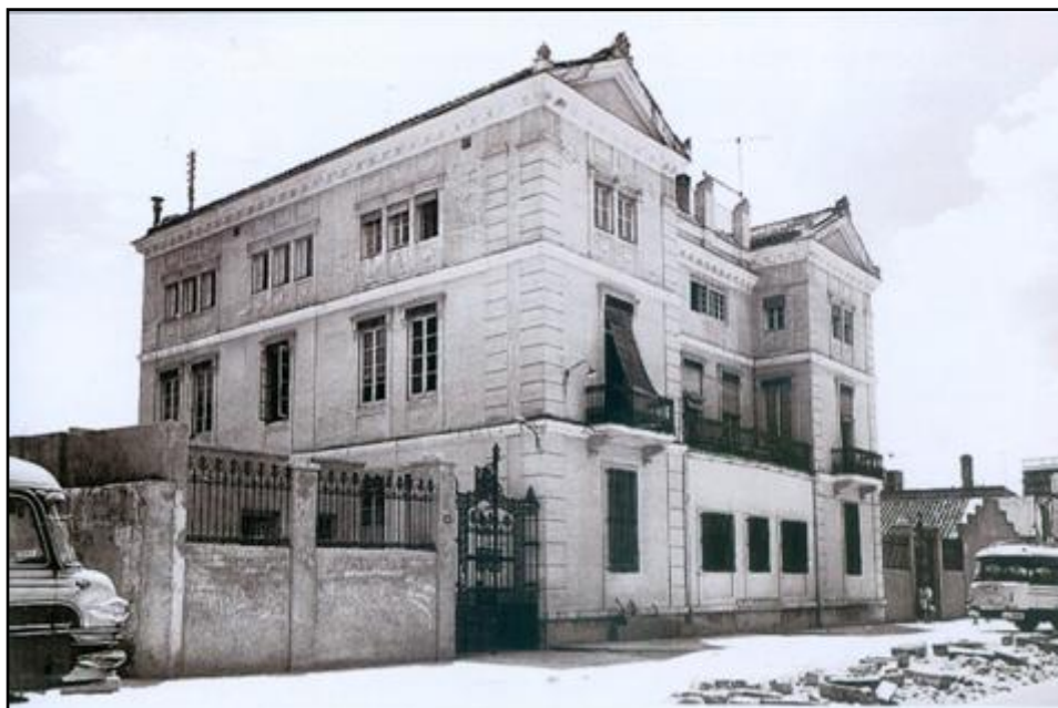
Fachada del Colegio en la calle Alboraya, nº 10
